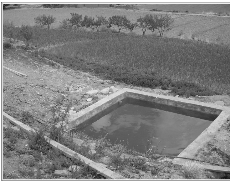
Construcción de reservorios para microriego.
