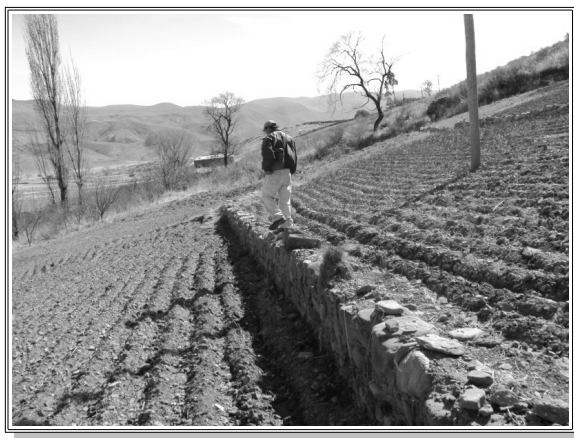
Construcción de terrazas.
