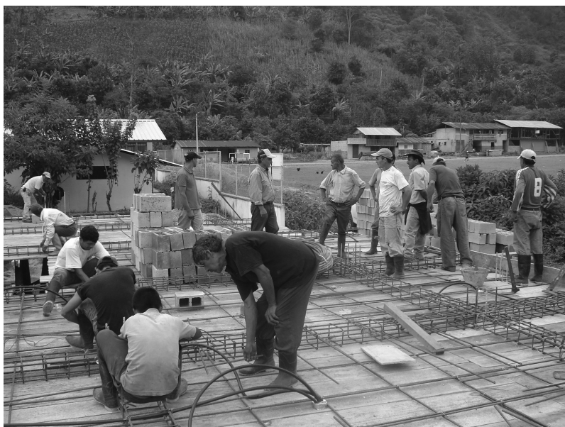
Construcción centro salud, Cotacachi, Ecuador
