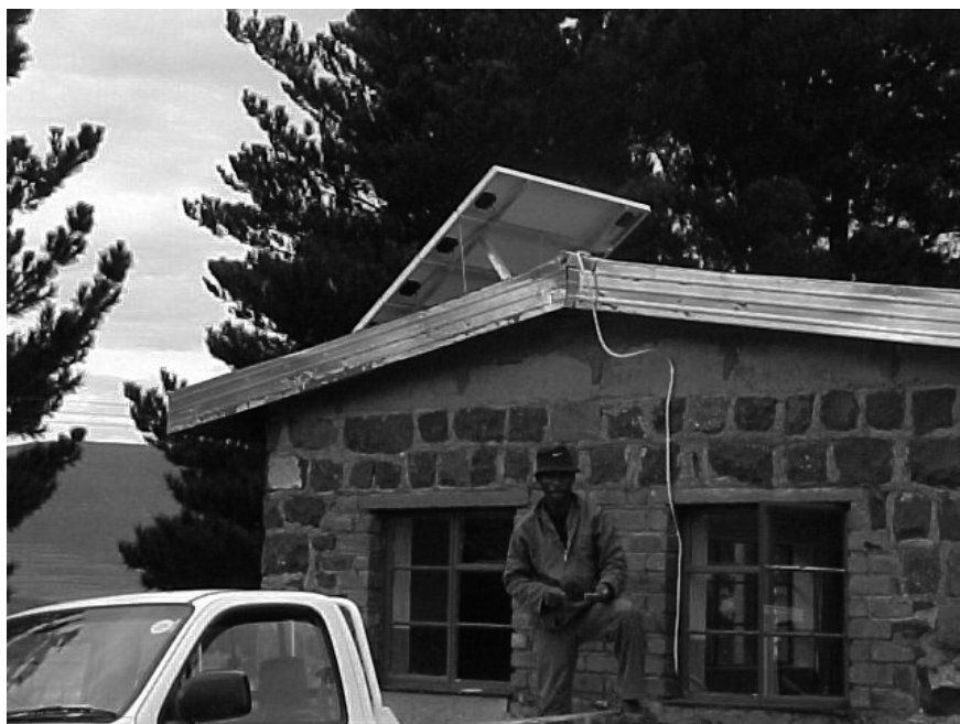
Electrificación de consultorio médico en Lesoto por parte de la colaboración cubana
