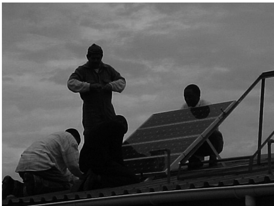
Instalación de paneles solares en Venezuela
